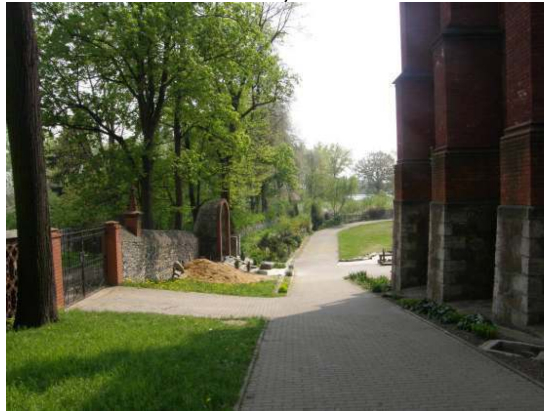
Fot. Mur kościoła
