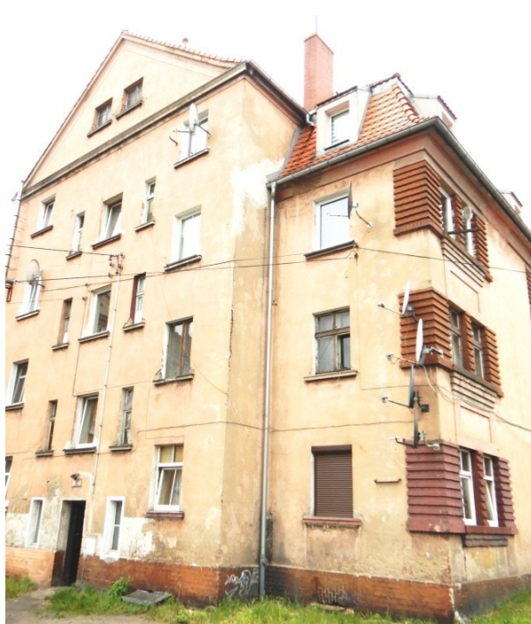
Ogólny widok budynku
